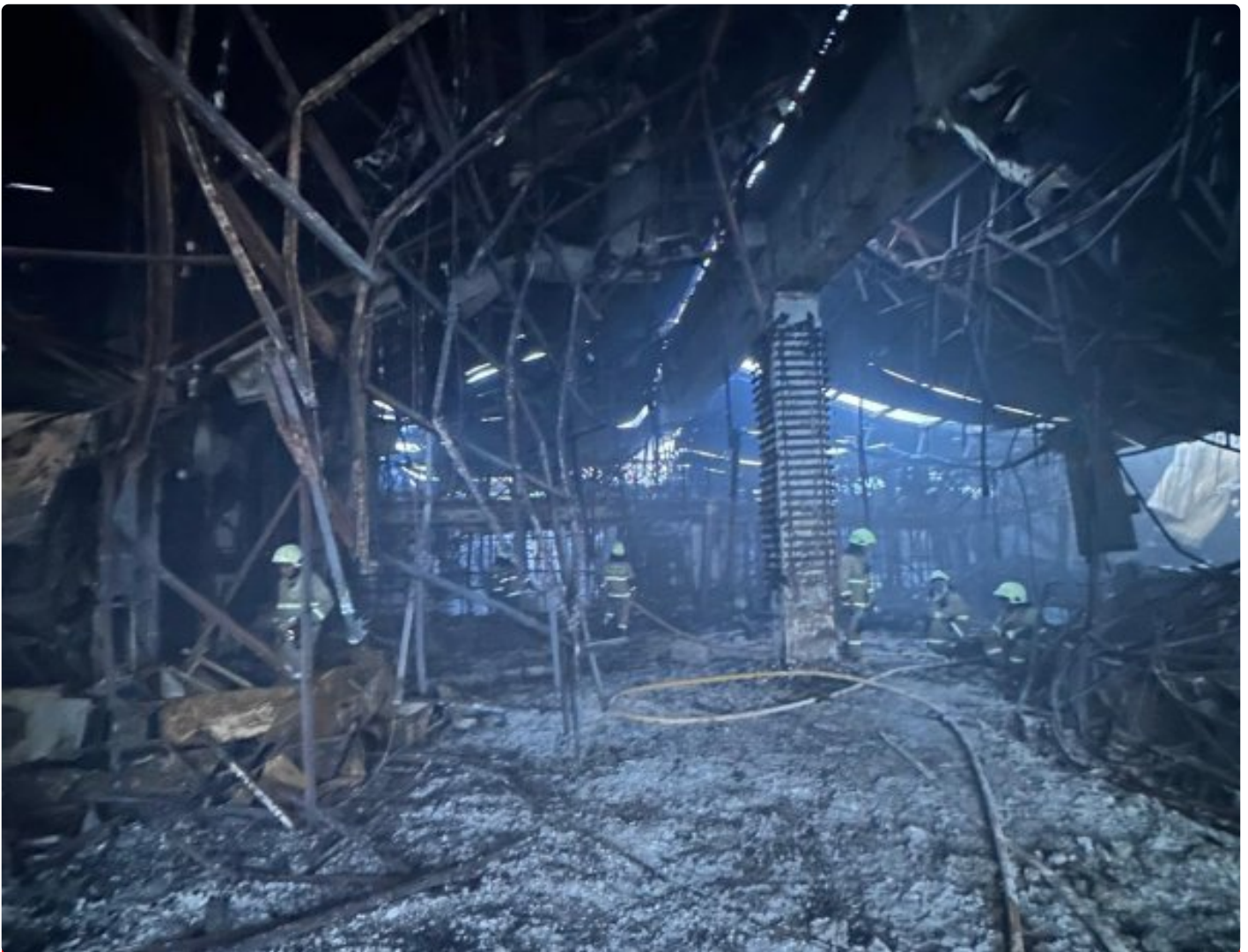
Glodok Plaza yang Hangus Terbakar
